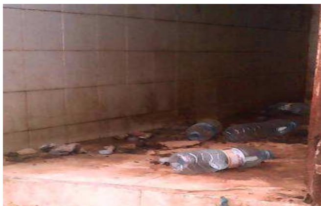
Les « toilettes » du centre de rétention du commissariat de Bagdad.
